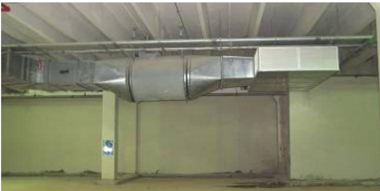
Sistema de extracción en el parqueo soterrado único en el país compuesto de 33 unidades de 44,000 CFM con motores de 30 HP así como extracciones de baños y áreas comunes a través de todo el edificio.
